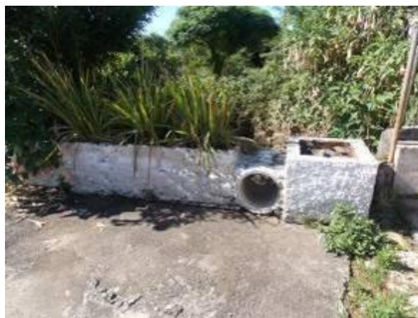
Imagem 18 e 19: Mostram o assoreamento do Arroio Veado e o tipo de escoamento irregular sobre pontilhão desta drenagem.
