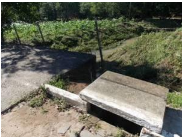
Imagem 17:Mostra a boca-de-lobo existente no município e ao fundo a macrodrenagem a qual é destinada as águas pluviais – Arroio Veado
