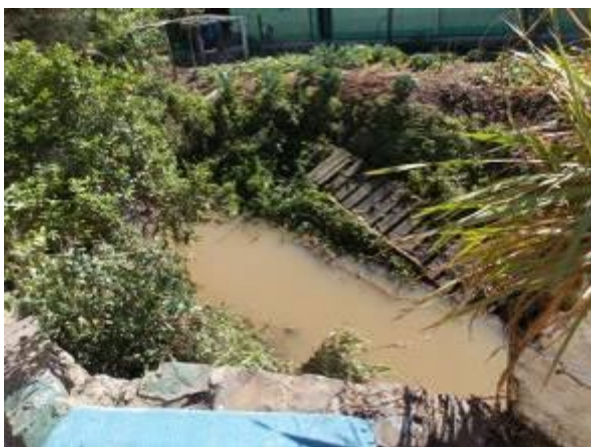
Imagem 18 e 19: Mostram o assoreamento do Arroio Veado e o tipo de escoamento irregular sobre pontilhão desta drenagem.
